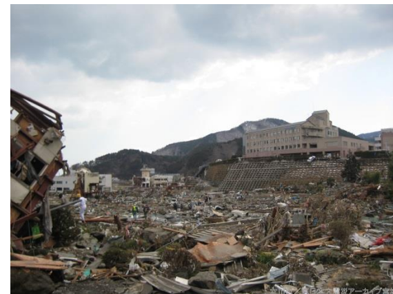
女川町の被害状況
