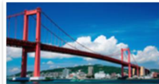
若松と戸畑を結ぶ若戸大橋
