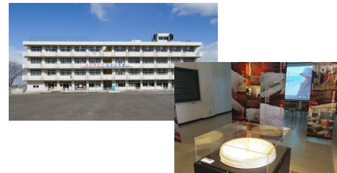
平成29年4月から一般公開を開始した 震災遺構仙台市立荒浜小学校
