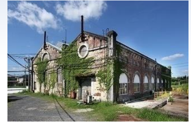
遠賀川水源地ポンプ室
