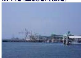
熊本港（重要港湾指定）
