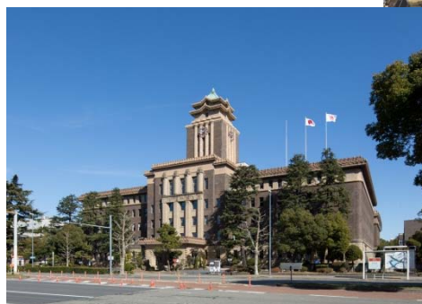
国指定重要文化財 名古屋役所本庁舎
