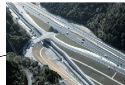
東九州自動車道が2年前倒して 県内全線開通 (H27年3月21日)
