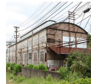
官営八幡製鐵所旧鍛冶工場
