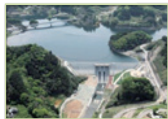
▲稲葉ダム(H22年完成)
