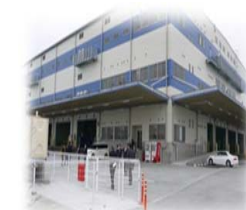
広域物流拠点の整備
