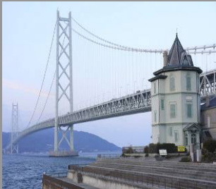
① 明石海峡大橋
