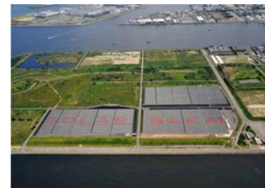
＜堺太陽光発電所＞
