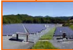
メガソーラー建設・誘致
