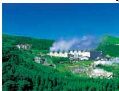
▲八丁原地熱発電 (九重町)
