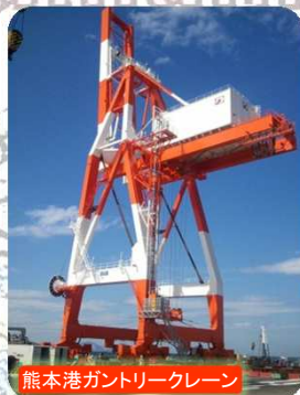
熊本港ガントリークレーン
