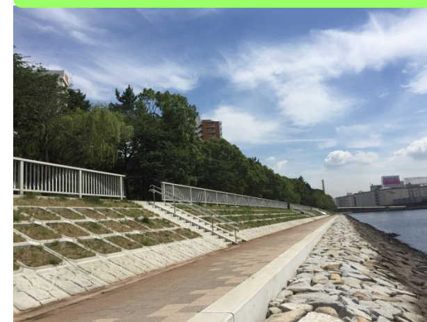
東京港・島しょ海岸保全施設整備事業
