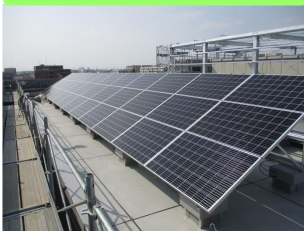
都府施設の改築・改修
