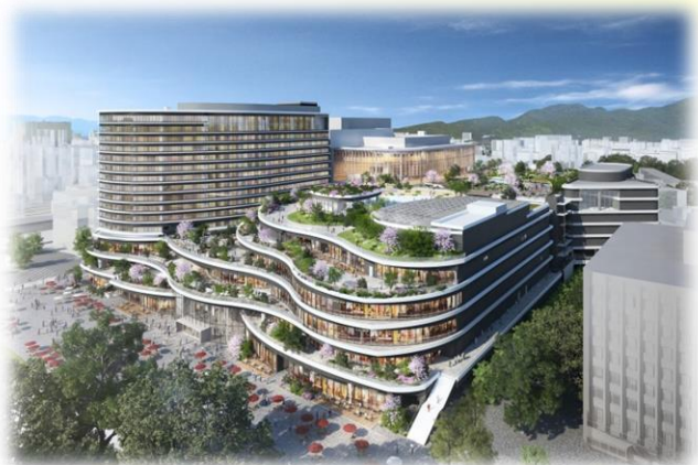
桜町地区再開発・熊本城ホール整備
