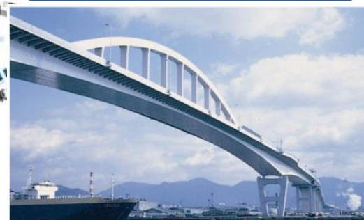
高速3号線宇品大橋
