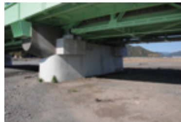
橋脚の補強(安倍川橋)
