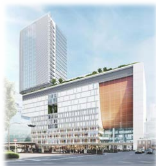
横浜駅西口駅前ビルの着工
