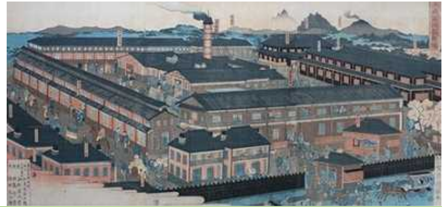
日本で最初の官営器械製糸工場[富岡製糸場]
