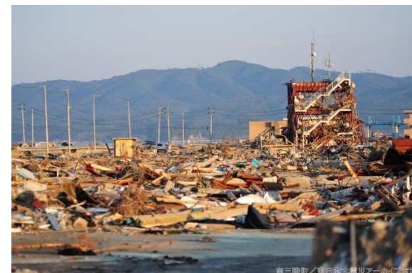
南三陸町の被害状況
