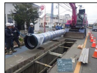
（耐震管の敷設工事）
