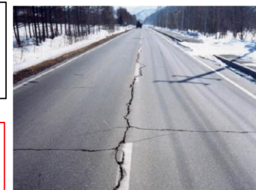
凍上災害による 舗装の損傷事例
