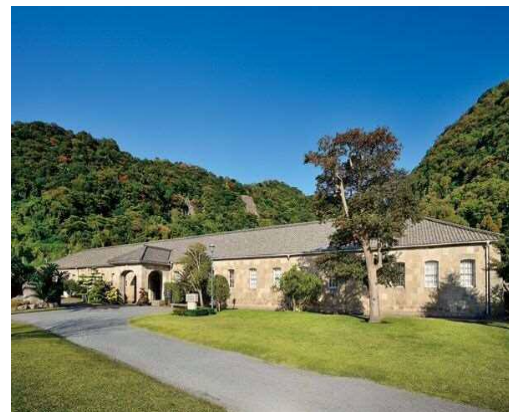
旧集成館機械工場
