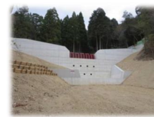
治山ダム（神戸市北区有野町唐櫃）
