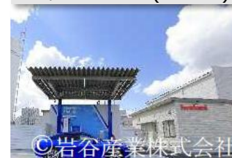
水素ステーション(姫路市)
