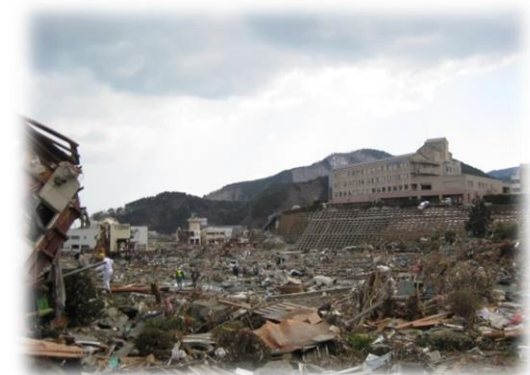
女川町の被害状況
