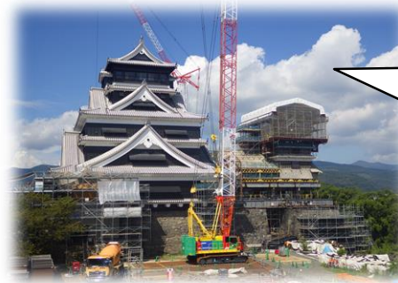
復旧工事中の熊本城
