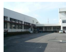
PF手法による 学校給食センター整備
