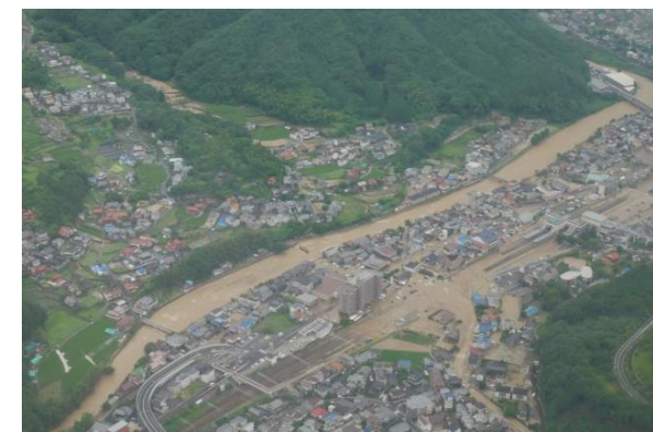
【瀬野川(広島市安芸区瀬野)】
