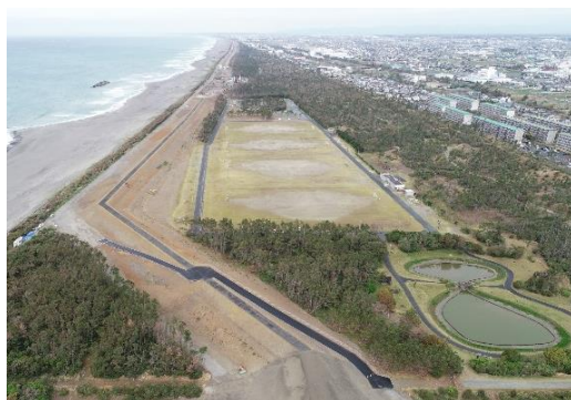
遠州灘に沿って整備される防潮堤 （浜松市）
