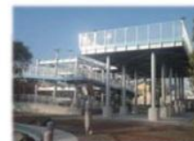
津波避難タワー
