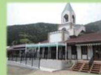
南アルプス 井川観光会館
