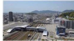
東静岡駅周辺基盤整備 平成28年3月完成予定
