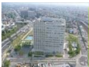
熊本合同庁舎A棟
