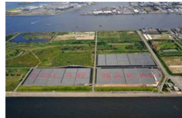
＜堺太陽光発電所＞
