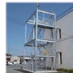
外付け階段設置
