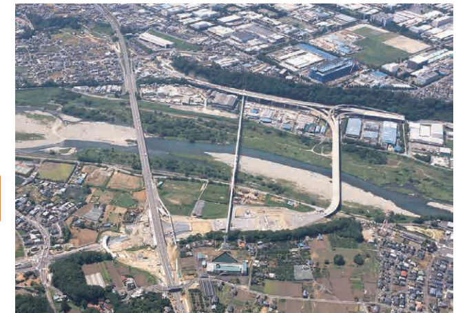
<さがみ縦貫道路 建設中の相模原愛川I.C.>
