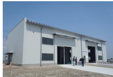
開設した関上仮設魚市場
