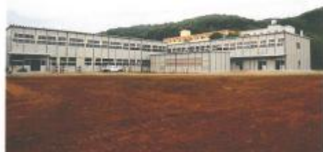
宮城県農業高等学校仮設校舎
