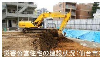
災害公営住宅の建設状況(仙台市)
