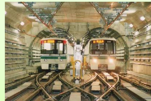
市営地下鉄海岸線〈夢かもめ〉
