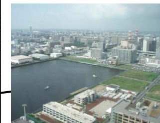
19年度に土地区画整理事業の整備が終わり、賑わいのある親水空間を創出するため、緑地プロムナードと小型客船が発着するさん橋の整備を進めています。
